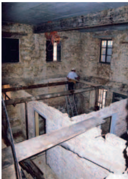
Rušenje lesenih stropov v hiši. Foto: D. Štepec, maj 2005. Arhiv ZVKDS, OE Novo mesto.
