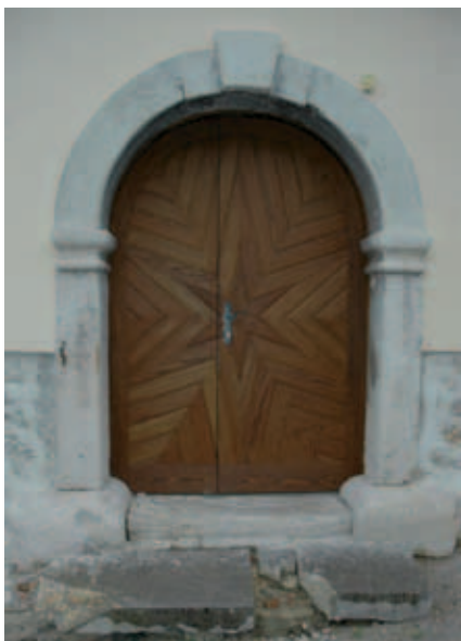
Obnovljena glavna vhodna vrata s poznobaročnim kamnitim portalom. Foto: D. Štepec, julij 2008. Arhiv ZVKDS, OE Novo mesto.
