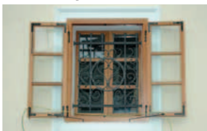
Obnovljena okna. Foto: D. Štepec, julij 2000. Arhiv ZVKDS, OE Novo mesto.
