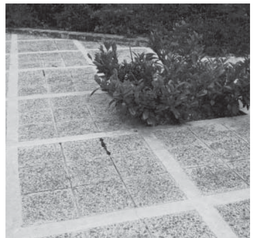
Detajl tlaka iz pranih betonskih plošč na ploščadi spomeniškega območja »Na vratih«. Foto: Marjan Mušič, Dolenjski muzej Novo mesto.
