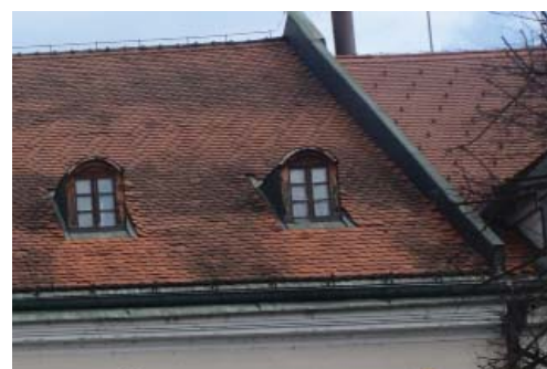
Primer ustrezno izvedenih frčad na Glavnem trgu. Foto: Tomaž Golob, 2014, ZVKDS OE NM.
