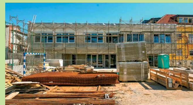
Investicija v prenovi OŠ Šmihel vključuje tako dozidavo učilnic, kabinetov in dvigala kot tudi celovito prenovi kuhinje, s čimer bo šola pridobila 650 m 2 novih površin.
