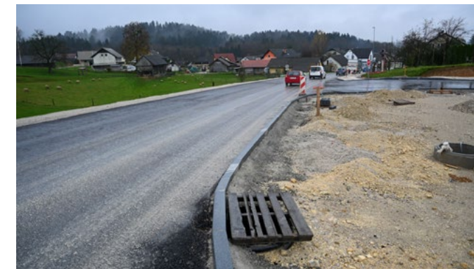
Večnamenska pot za pešce in kolesarje med Malim Slatnikom in Petelinjekom
