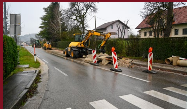
Ob regionalni cesti na Ratežu se ureja manjkajoči pločnik v dolžini 131 metrov, naselju pa se v prihodnje obeta tudi preureditev osrednjega križišča v krožišče.
