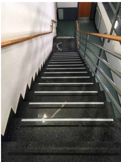
Namestitev kontrastnih protizdrsnih označb na robovih stopnic v KCJT. Foto: arhiv društva
