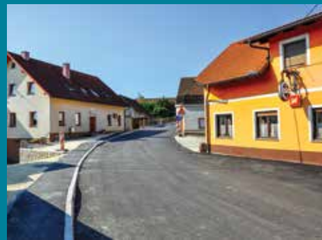
Obnova ceste v Šmihelu.
