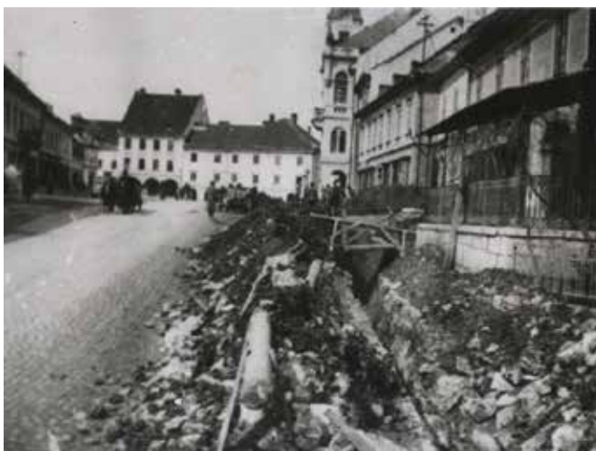
Gradnja vodovoda v Novem mestu leta 1901 (vir: Komunala Novo mesto).
