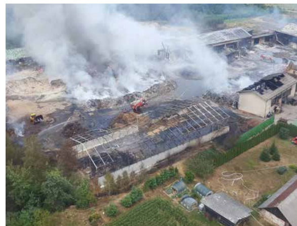
Drugi dan intervencije, pogled na požarišče iz zraka, JZ del
