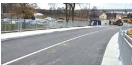
Ozko prometno grlo pri mostu na Težki vodi je dočakalo prenovu. (16)
