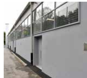
Športna dvorana Marof ima po energetske sanaciji novo, lepšo preobleko. (13)
