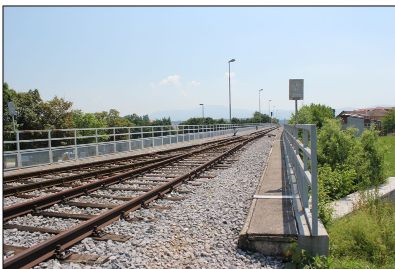
- železniški nadvoz pri pokopališču Šmihel -
