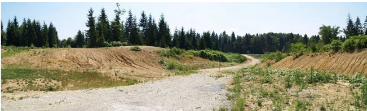
Slika 5: pogled na južni del Podbreznika – še nezgrajeni del območja (pogled proti jugu).
