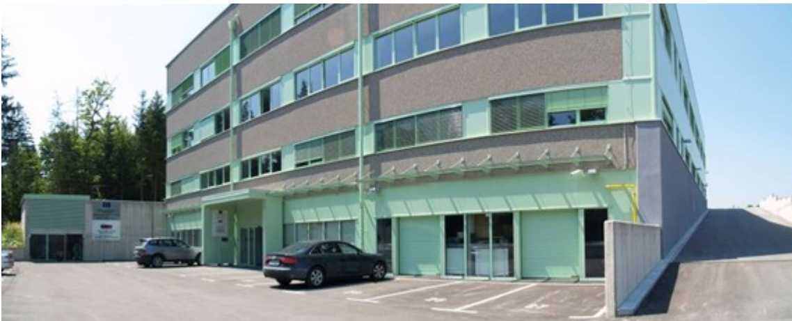
Slika 4: pogled na severovzhodni del Podbreznika – že zgrajeni poslovni objekti (pogled proti JV).
