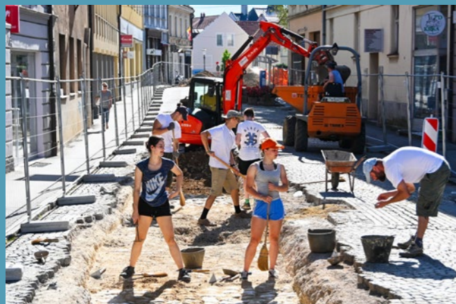
Arheologi so ob nadaljevanju prenove mestnega jedra na Rozmanovi ulici odkrili novomeško tlakovano cesto; kar se skriva pod njo, bodo še razkrili.
