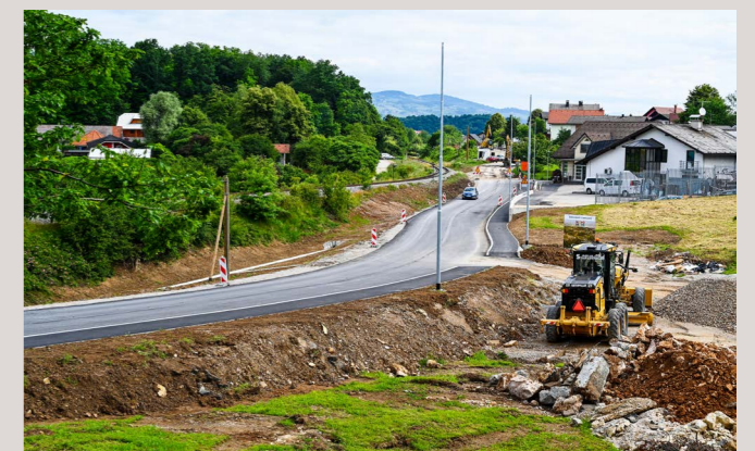
V Šmihelu lahko v teh dneh že opazite sveže asfaltirano cesto. Preostali del Šmihelske ceste je še vedno v procesu prenove, ki bo predvidoma zaključena v juliju.
