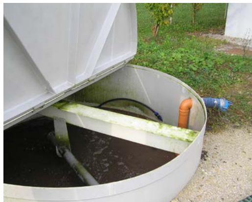
Slika 5.4: Silos odvečnega blata na ČN Brusnice
