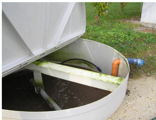
Slika 4: Silos odvečnega blata na ČN Brusnice
