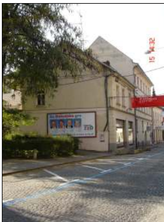
- obstoječi objekt Rozmanova 11, ki se odstrani -
