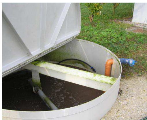
Slika 5.4: Silos odvečnega blata na ČN Brusnice
