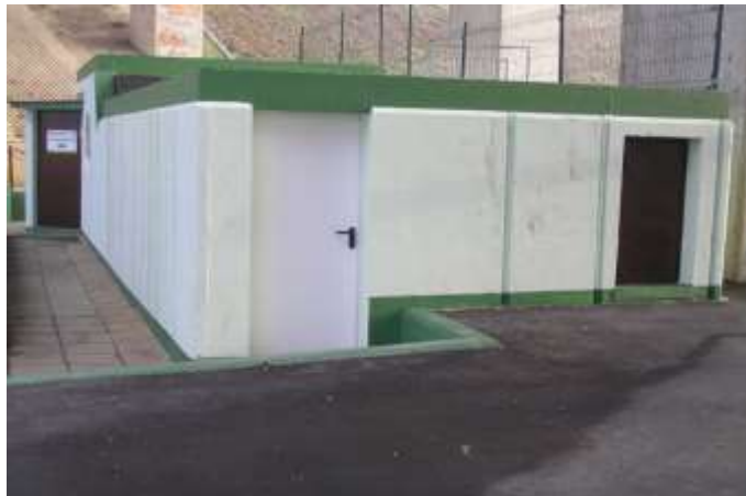
Slika 6: Črpališče Loka pod Šmihelskim mostom
