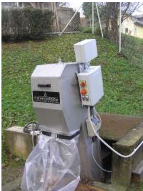
Slika 1: Grablje na dotoku ČN Otočec
