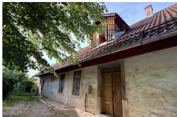
Slika 5: Pogled na južno fasado
