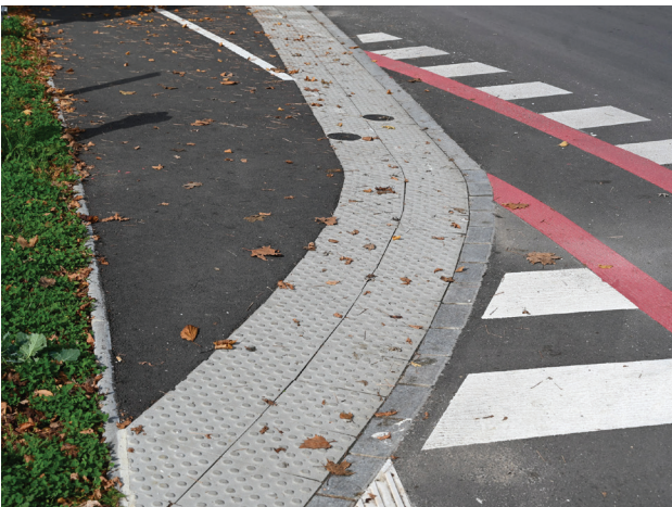
Slika 20 ; Odprava nevarnih prehajanj kolesarjev iz kolesarskih površin na vozišče in obratno po vzoru ureditve na Ulici Slavka Gruma predstavlja eno od ključnih področij ukrepanja.
