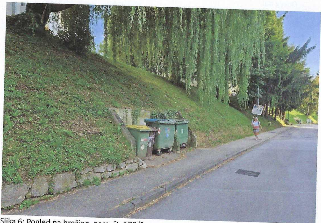
Slika 5: Pogled na brežino, parc. št. 182/1
