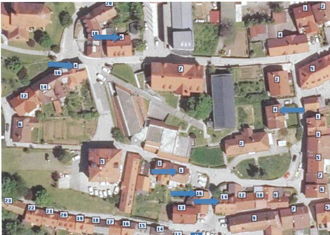
Slika 6: Hrupu najbolj izpostavljene stavbe z varovanimi prostori (VIR: PISO, 28.02.2022)
