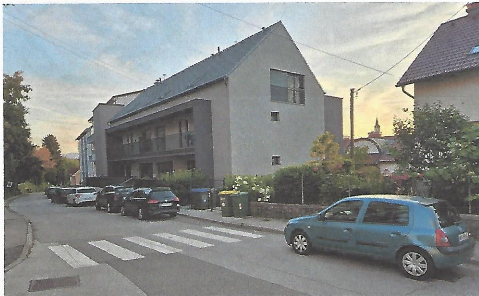
Slika 4: Dejansko parkiranje – pogled od hišne št. 11a proti 9
