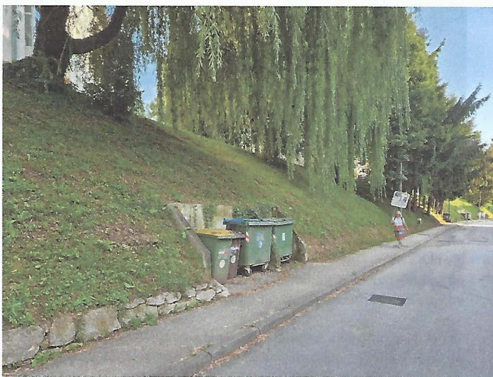
Slika 3: Brežina na levi strani ulice gledano v smeri centra (parc. št. 178)
