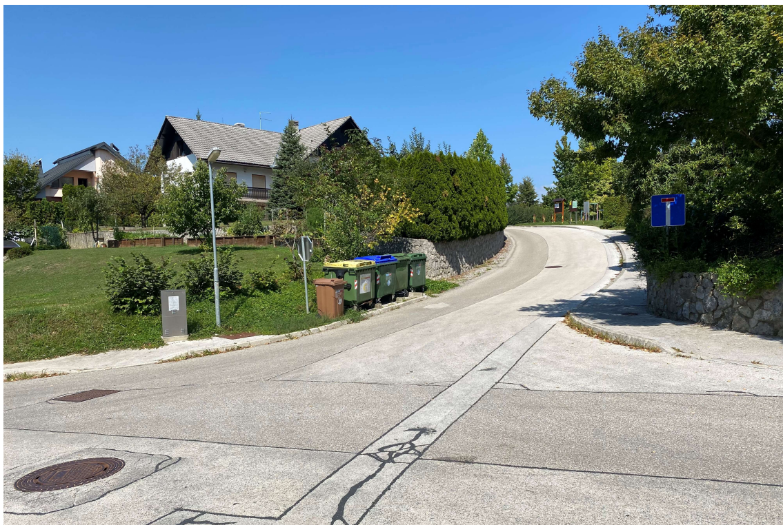
Slika 6: Zaključek ceste "A"
